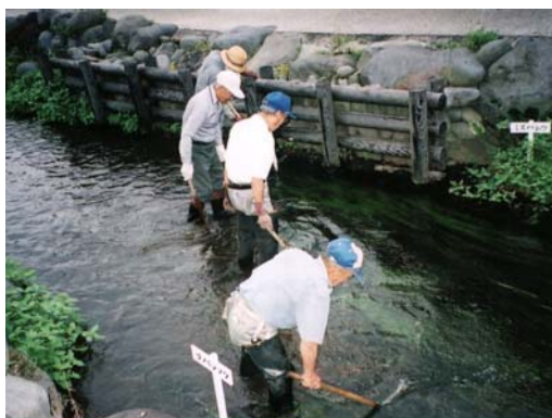
水路の維持管理作業
