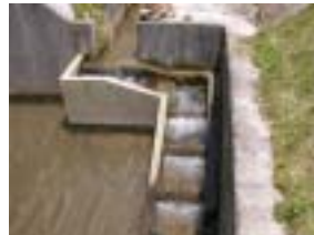
配慮施設の例（段差解消水路）
