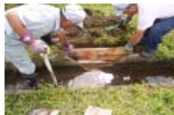
U字溝の改修作業
