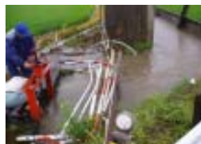
ゲートへのごみや流木の流入状況
