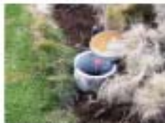
洗掘口の奥きもほ場面に合わせた給水栓ボックス
