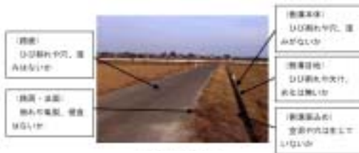
ため池の点検ポイント
