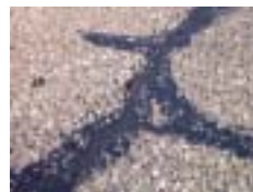
ひび割れの補修（路面） （アスファルト乳剤系補修材による補修）
