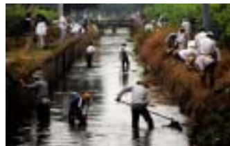
水路の泥上げ状況
