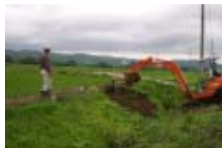
農用地法面の補修
