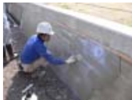
コーティング作業の状況
