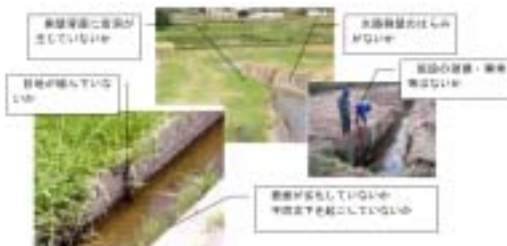
開水路の点検ポイント
