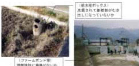
パイプラインの点検ポイント
