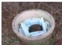
給水栓ボックス内の保温状況
